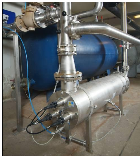
UV anlæg type Spektron 70 med en ydelse på 108 m 3 /h. Anlægget er installeret på et dansk mejeri.
